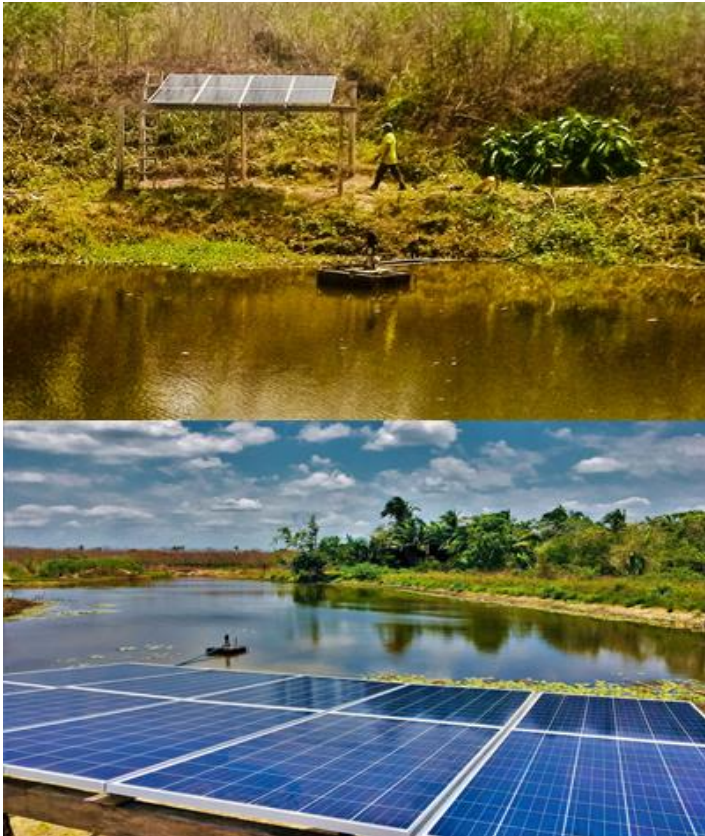
Figura 4. Unidades de bombeamento solar de água nas dependências da ONG EMA, nos municípios de Cantanhede (acima) e Pirapemas (embaixo).
